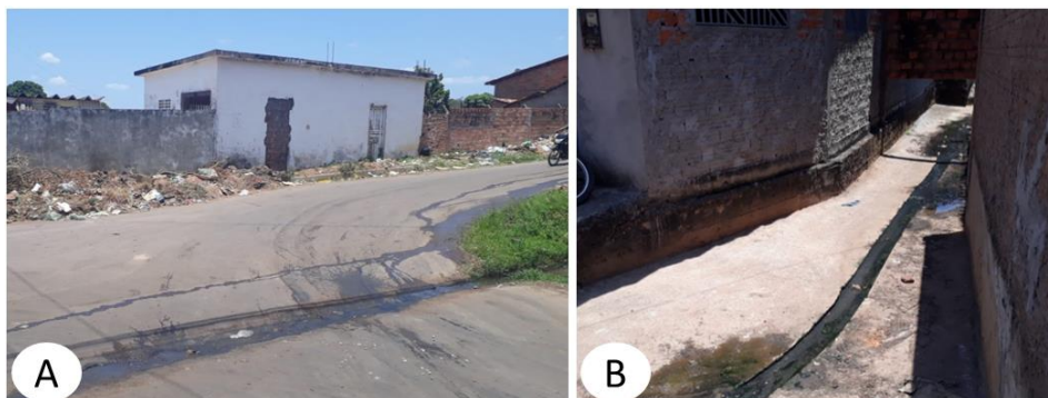
Figura 7: Esgoto a céu aberto no bairro São Pedro em Codó. A: ao lado do HGM; B: na rua Mandacaru.
