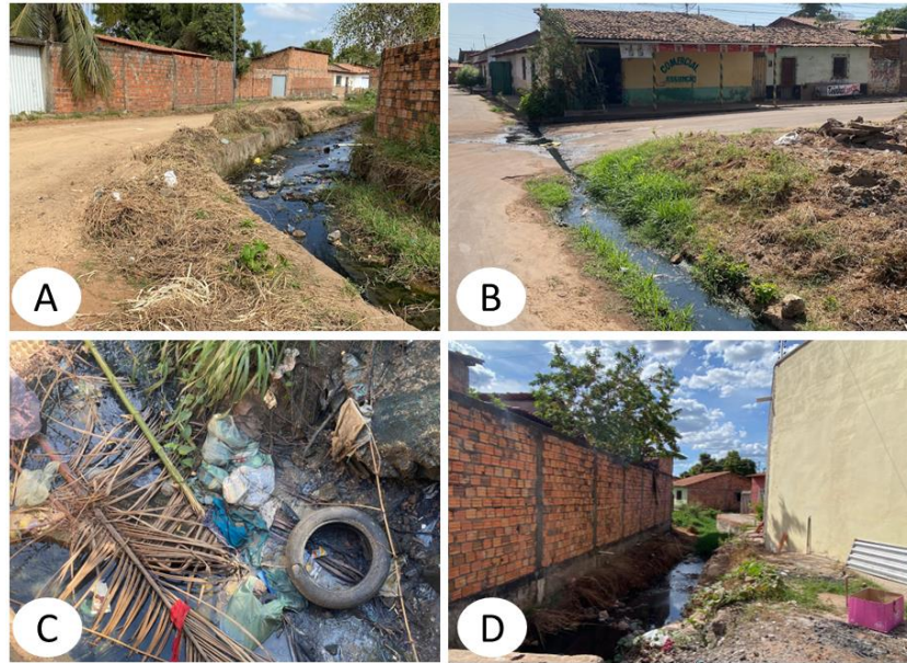
Figura 6: Esgotos a céu aberto no bairro Santo Antônio em Codó.
