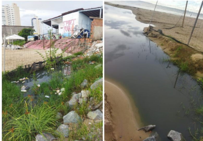
Figura 8: Despejo de esgoto in natura nas areias da praia da Ponta D´areia
