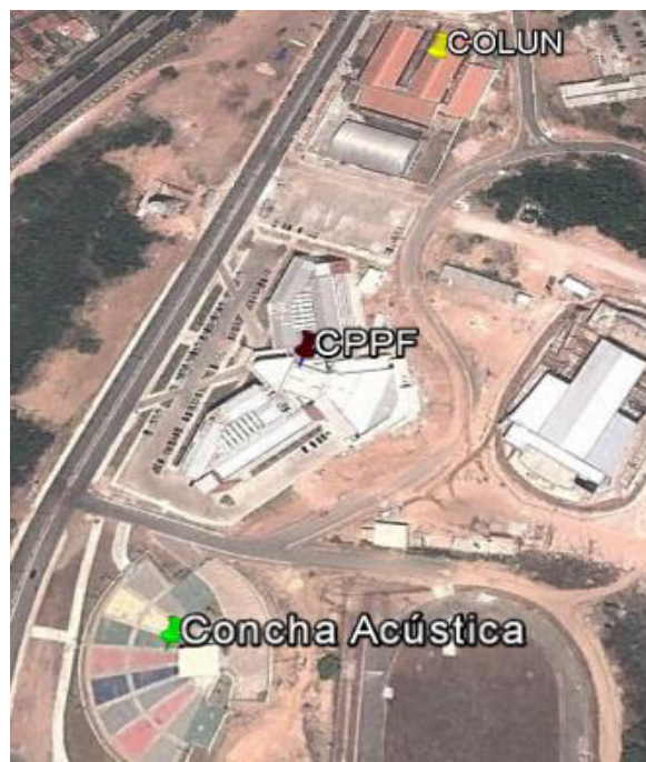
Figura 8 - Vista aérea do CPPF
