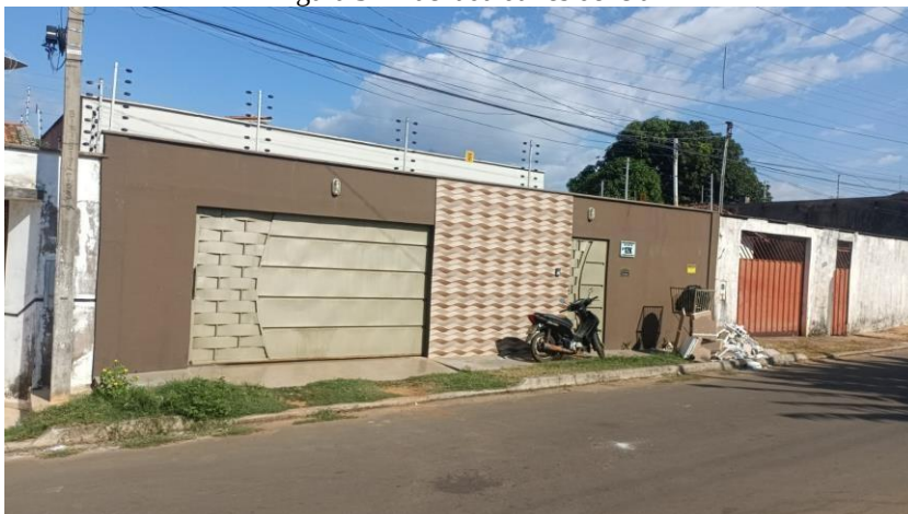
Figura 3 – Fachada da residência
