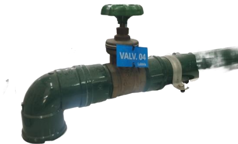
Figura 13 – Válvula gaveta.
