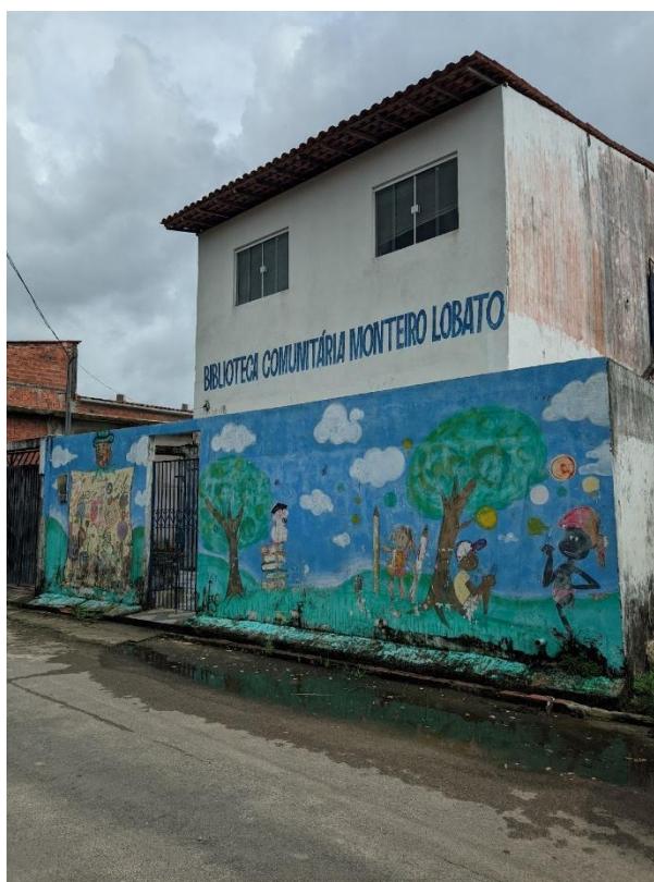
Figura 8 - Dependências da escola Irmã Maria do Socorro (Biblioteca Comunitária Monteiro Lobato)
