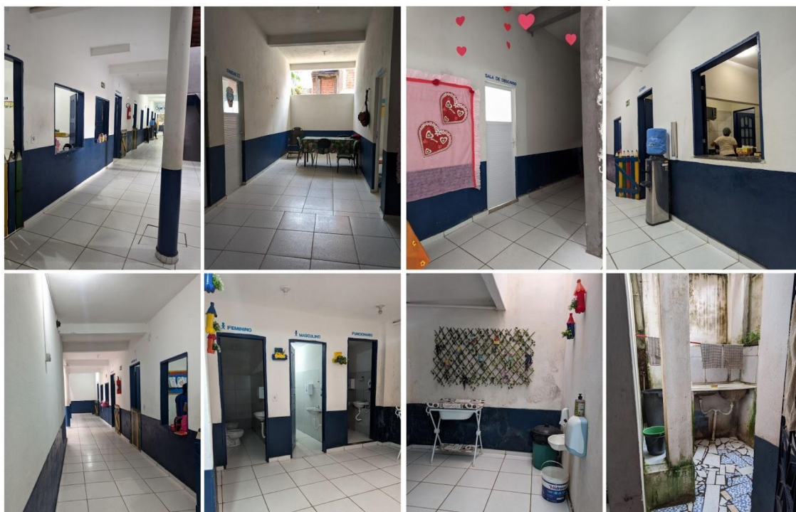
Figura 6 - Dependências da escola Irmã Maria do Socorro (Creche I e Creche II, Pré Escola I, Pré Escola II, Sala de Descanso, Cozinha, Banheiros feminino, masculino e de funcionários, lavabo e lavanderia)
