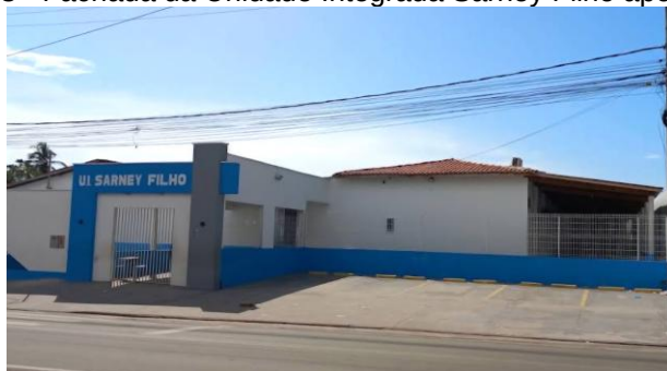
Figura 3 - Fachada da Unidade Integrada Sarney Filho após reforma
