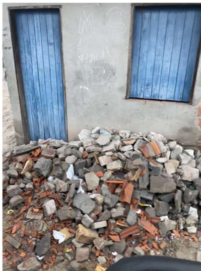
Figura 17: Imagem do descarte inadequado de resíduos sólidos provenientes da construção civil.
