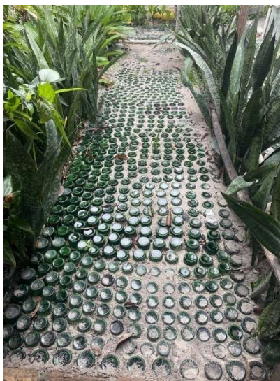
Figura 8 - Imagem de passarela construída a partir do aproveitamento de resíduos sólidos
