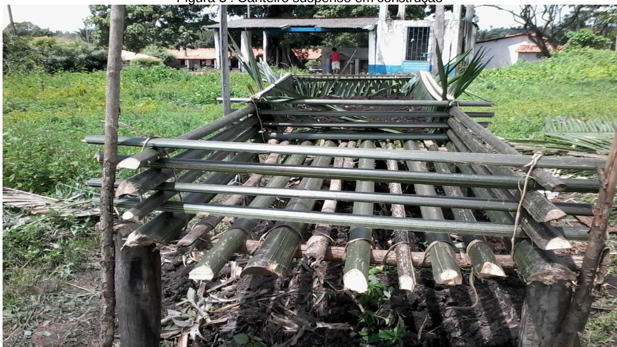
Figura 3 : Canteiro suspenso em construção
