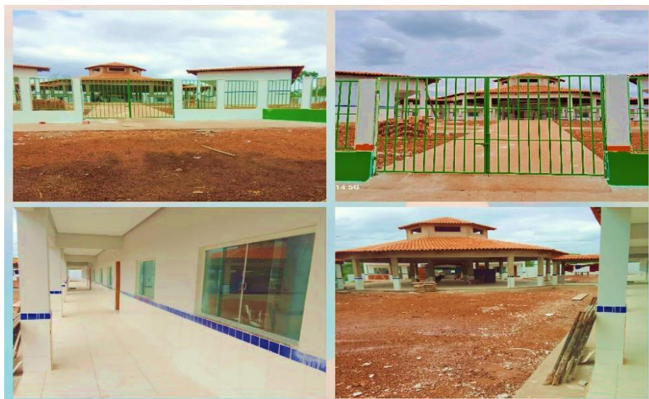
Figura 6 – Construção da Nova Escola dentro da Aldeia Taboca.
