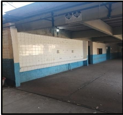
Fig.1 - bebedouro da escola.
