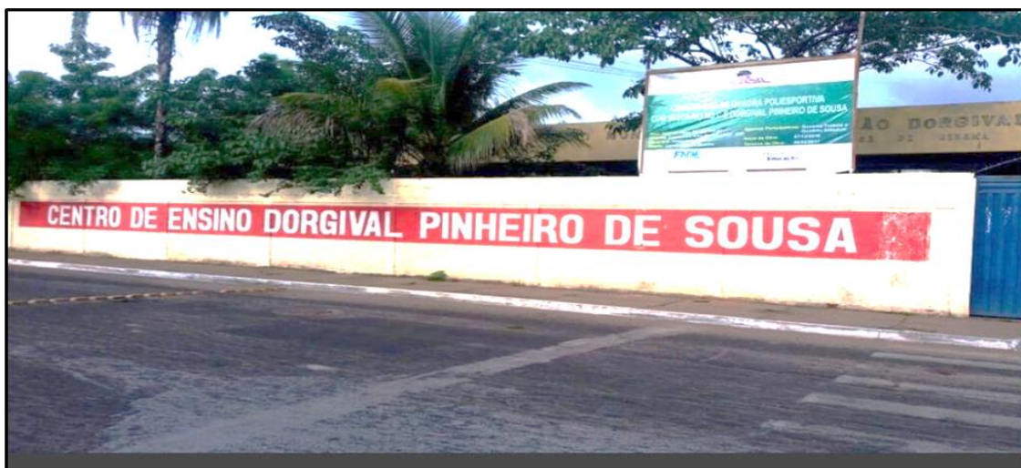
Figura 01 - Fachada da Escola: Centro de Ensino Dorgival Pinheiro de Sousa
