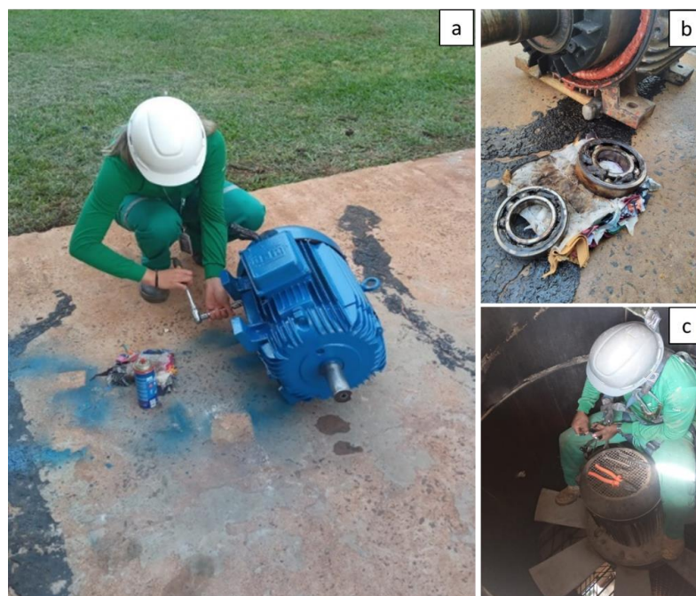
Figura 6 -Limpeza e substituição dos rolamentos dos exaustores.
