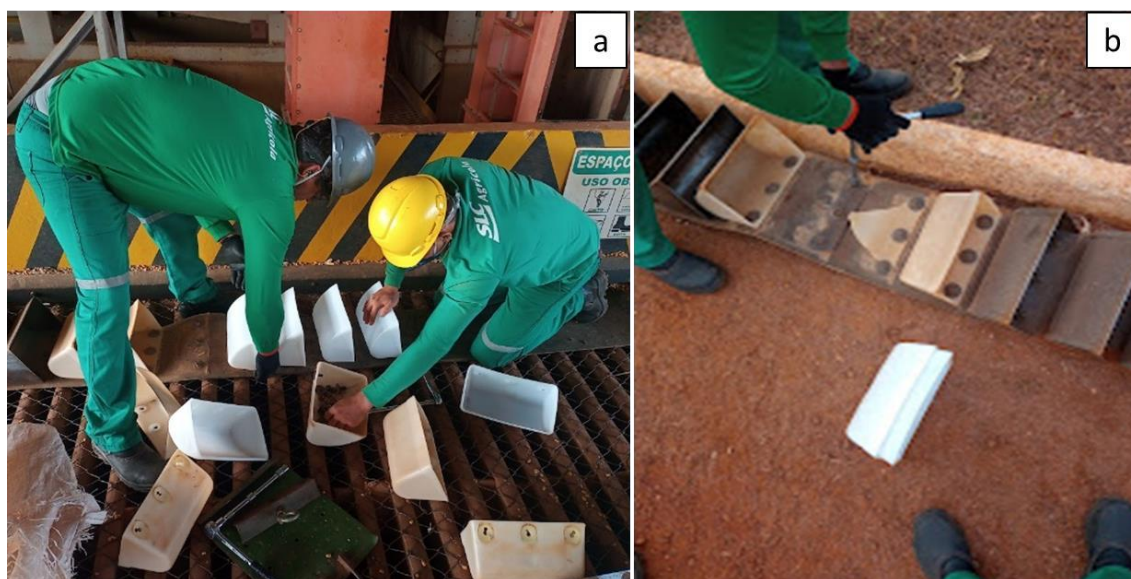
Figura 8- Trocas de canecas com defeitos.
