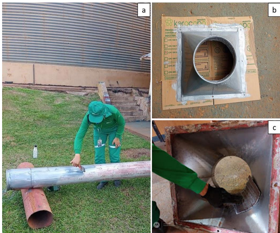
Figura 5- Manutenção nos canos do silo.
