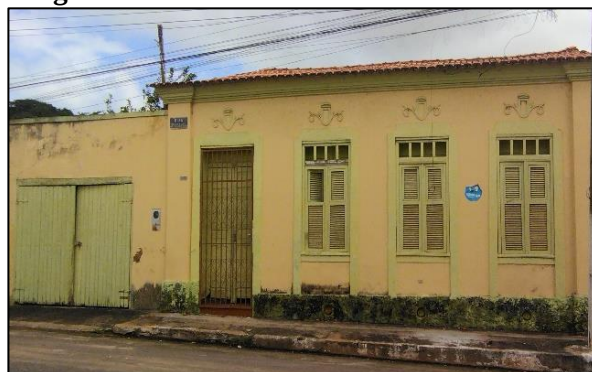
Figura 2 – Casarão no bairro Trizidela
