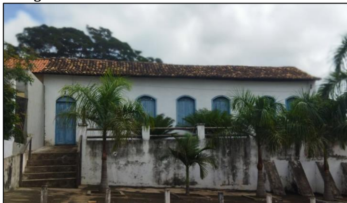
Figura 3 – Casarão no bairro Trizidela
