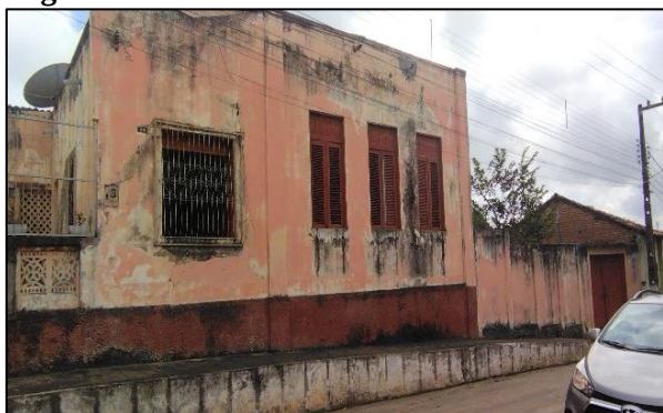
Figura 1 – Casarão no bairro Trizidela
