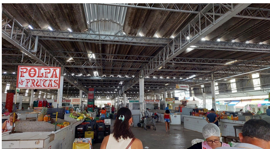
Figura 19: Interior do Mercado Municipal da Liberdade.
