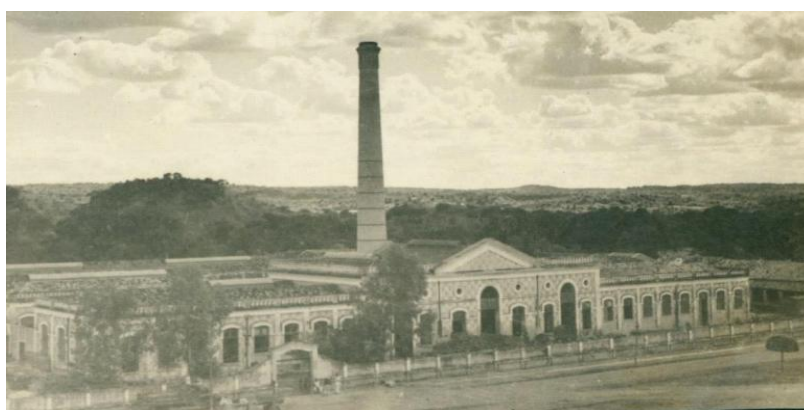
Figura 4 - Fachada da fábrica Manufatora Caxiense
