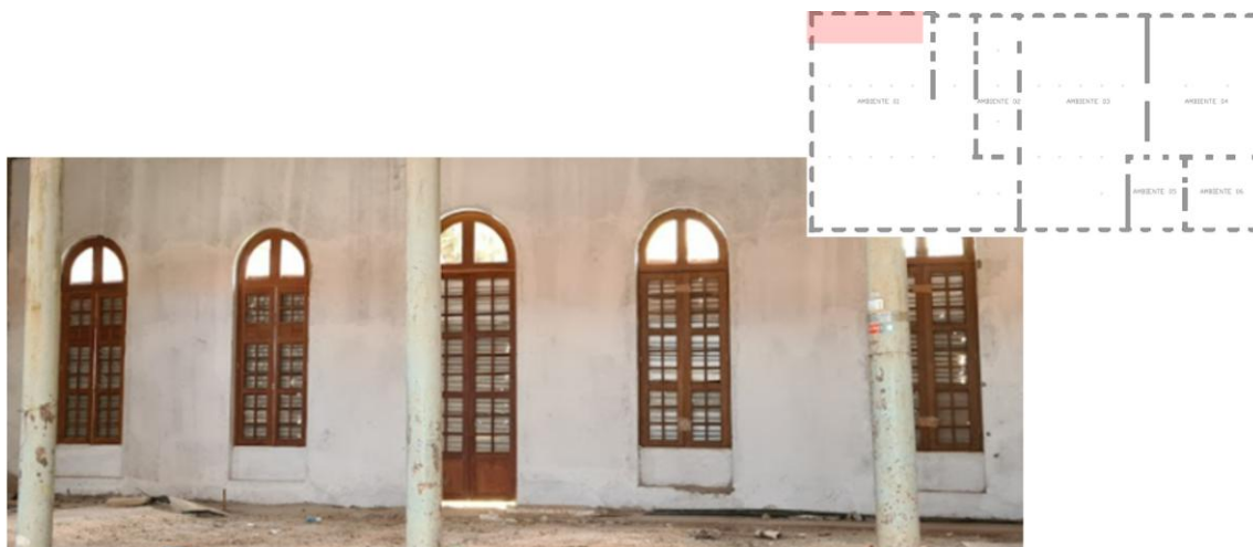
Figura 47 - Novas esquadrias instaladas no ambiente 01
