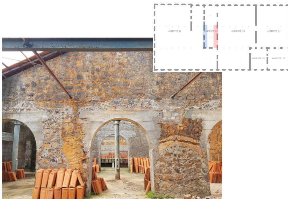
Figura 49 - Fechamento de vãos entre ambientes 01 e 02
