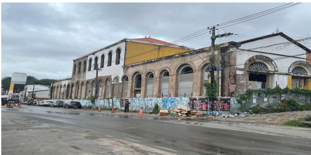
Figura 13 - Fachada principal do Prédio da Companhia Progresso Maranhense
