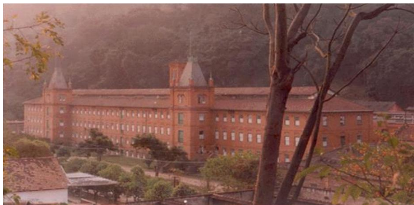
Figura 3 - Edifício da antiga Cia. Têxtil Brasil Industrial
