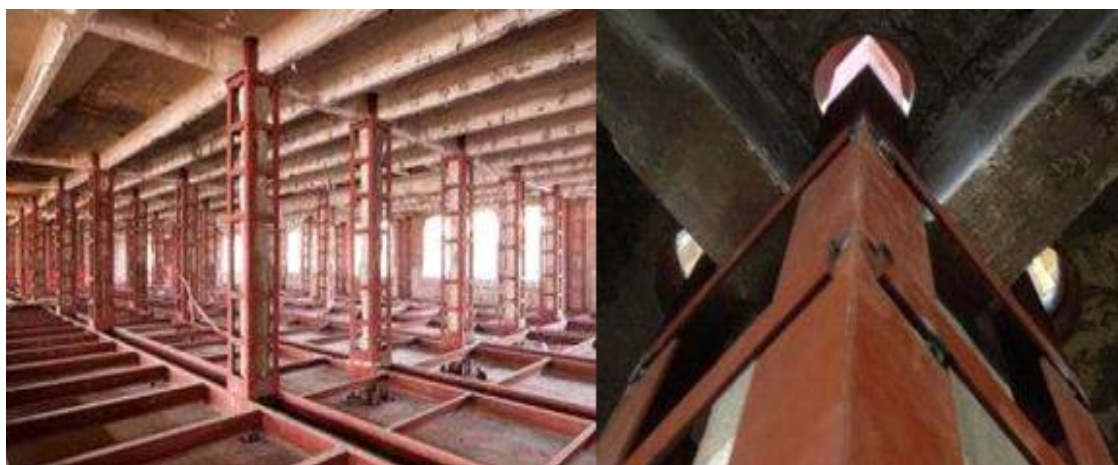
Figura 23 - Estruturas de reforço de pilar: Nova estrutura dos pilares (esquerda) e aberturas na laje para dar acesso à estrutura de reforço (direita)
