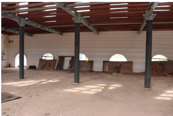
Figura 35 - Estrutura do assoalho de madeira do mirante
