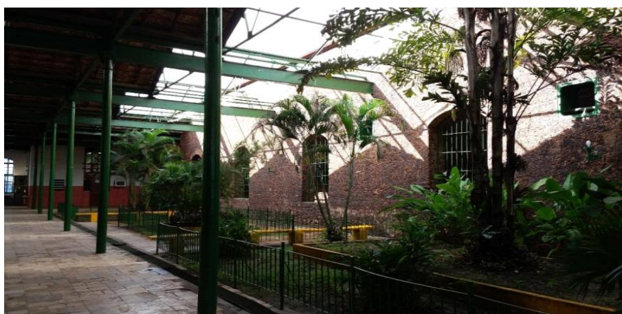
Figura 8 - Estruturas metálicas e parede em alvenaria de pedra no interior do prédio da antiga fábrica do Rio Anil
