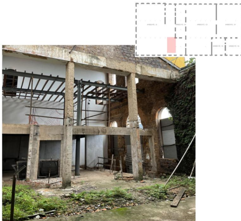
Figura 41 - Pilares e vigas de concreto armado no ambiente 01
