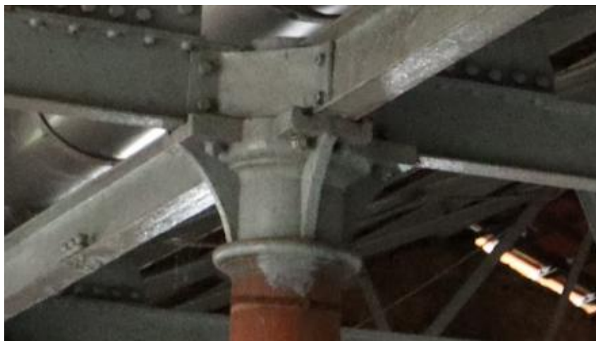
Figura 28 - Vigas metálicas ligadas
