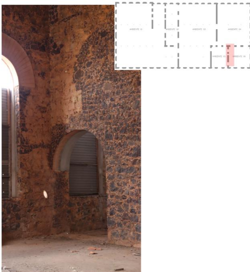
Figura 50 - Fechamento de abertura entre os ambientes 05 e 06
