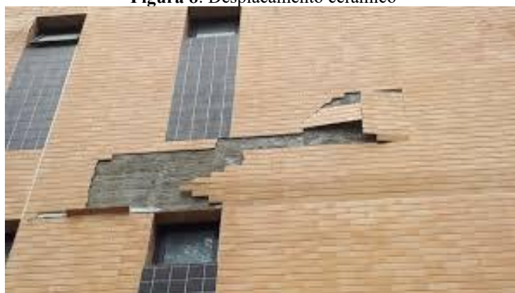
Figura 8: Desplacamento cerâmico
