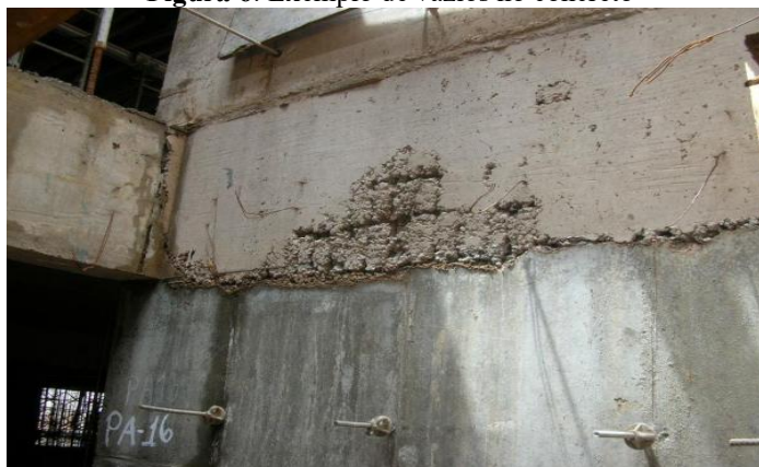
Figura 6: Exemplo de vazios no concreto
