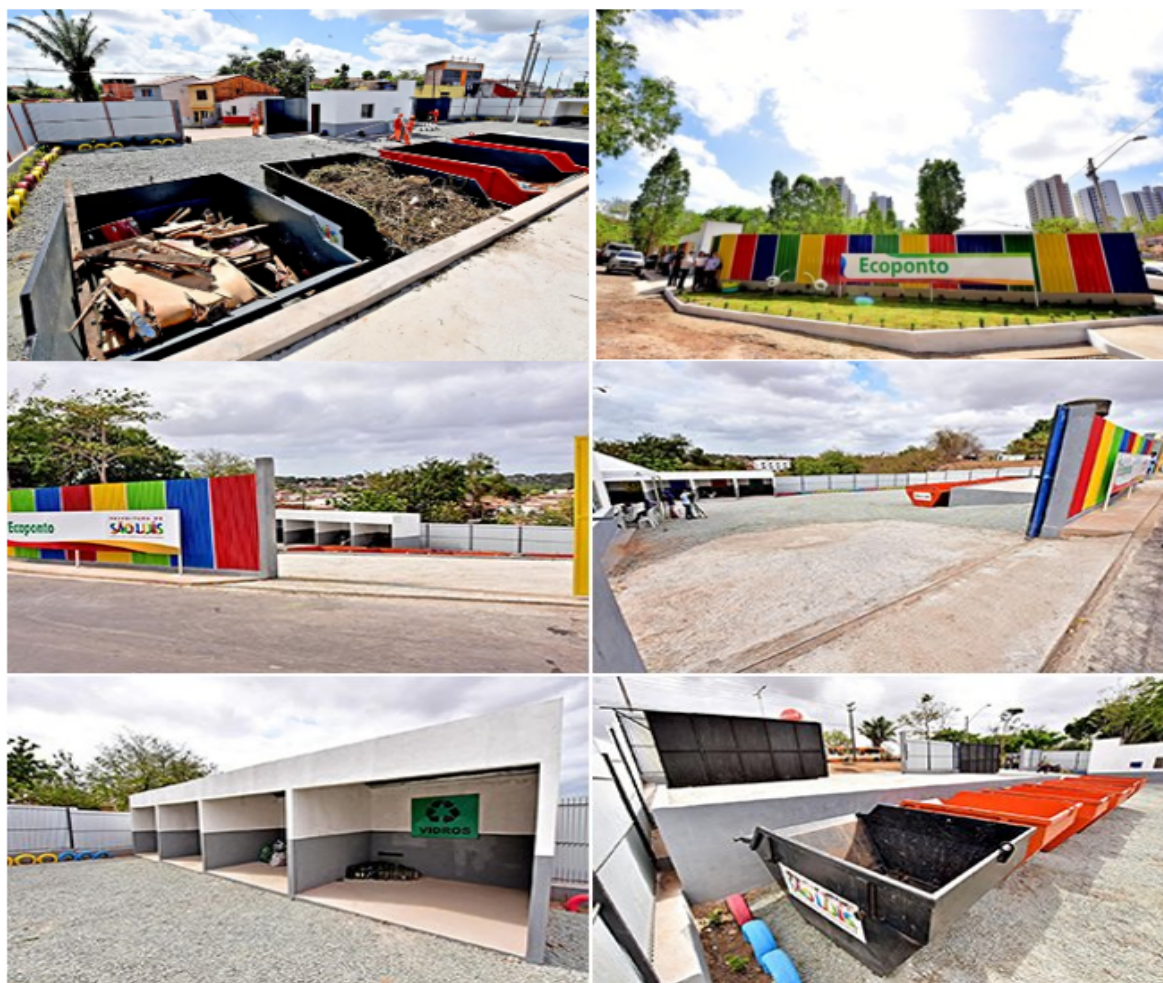
Figura 8 – Estrutura dos Ecopontos de São Luís – MA
