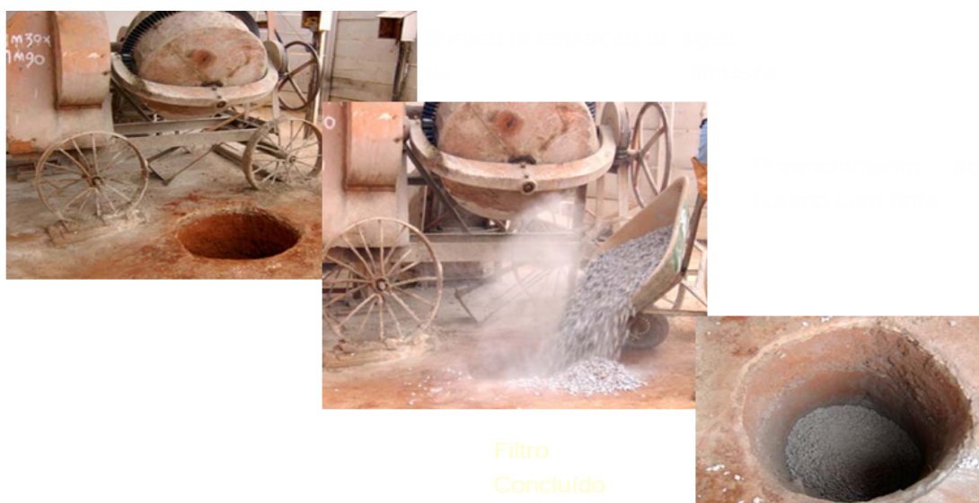
Figura 11 – Construção do filtro para água da lavagem da betoneira
