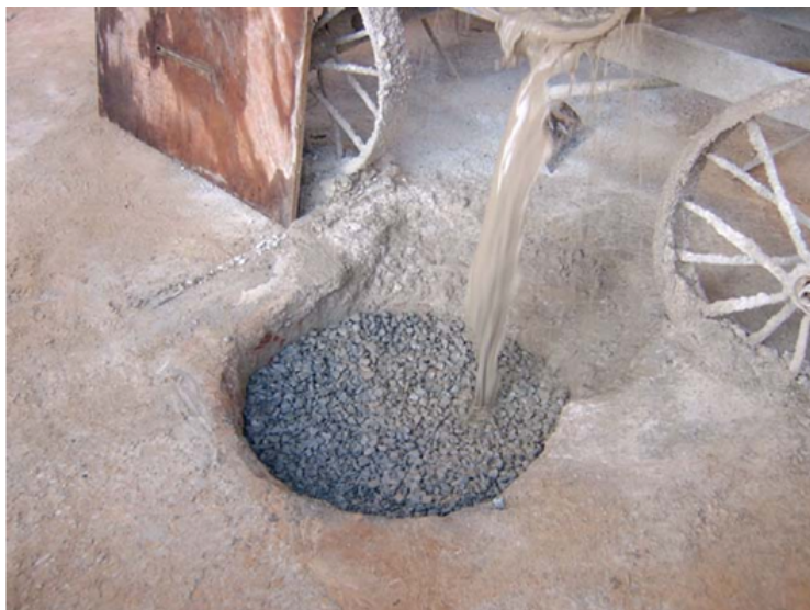
Figura 12 – Filtro em uso para reaproveitamento da água
