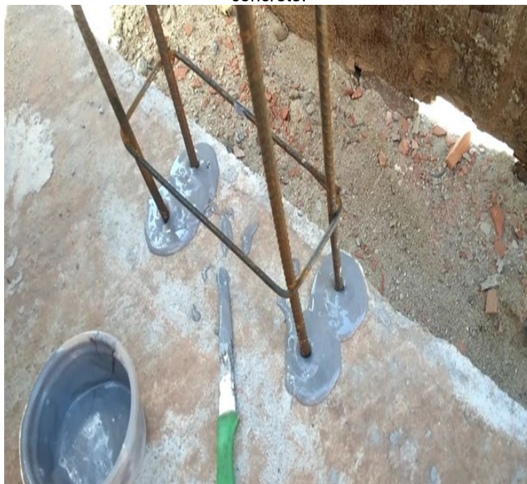
Figura 33 - Pintura epóxi como barreira de proteção química e adesiva entre armadura e base de concreto.
