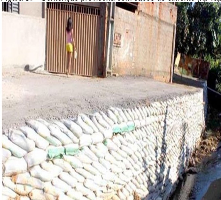
Figura 37 - Contenção provisória com sacos de cimento (rip-rap)
