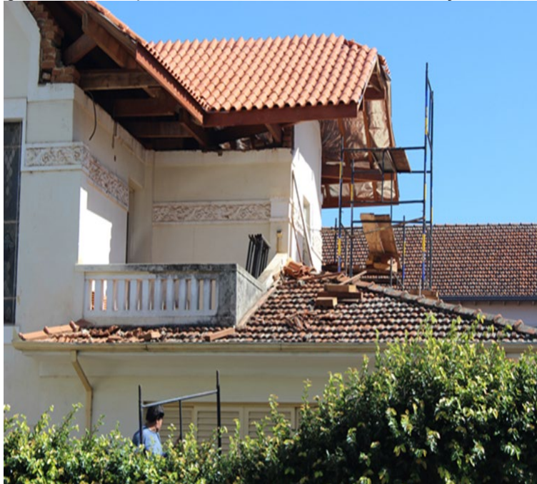
Figura 40 - Exemplo de reforma de telhado em edificação histórica.
