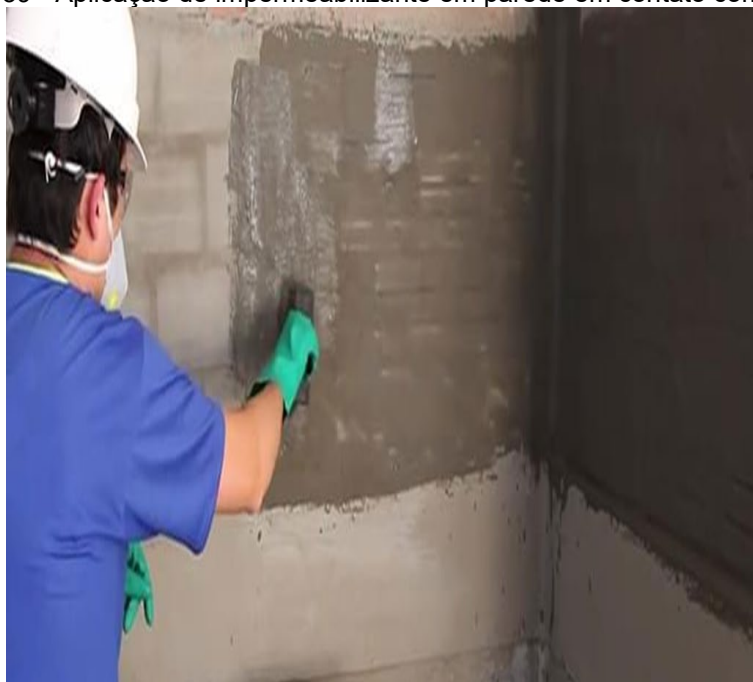
Figura 39 - Aplicação de impermeabilizante em parede em contato com o solo.
