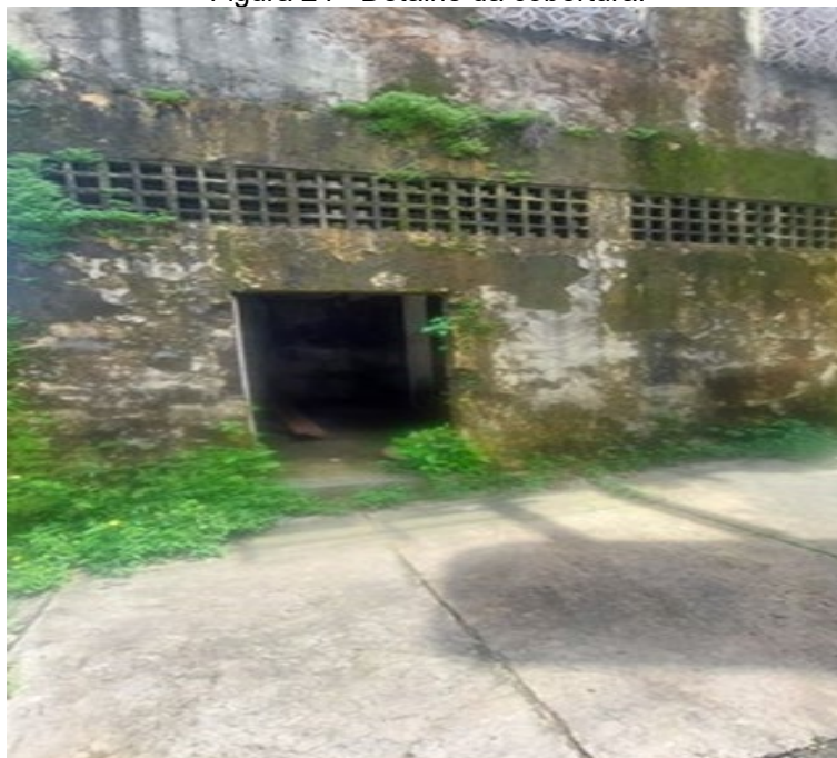
Figura 24 - Detalhe da cobertura.
