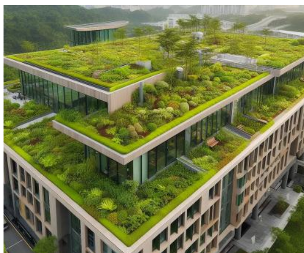
Figura 1 - Exemplo de telhado verde
