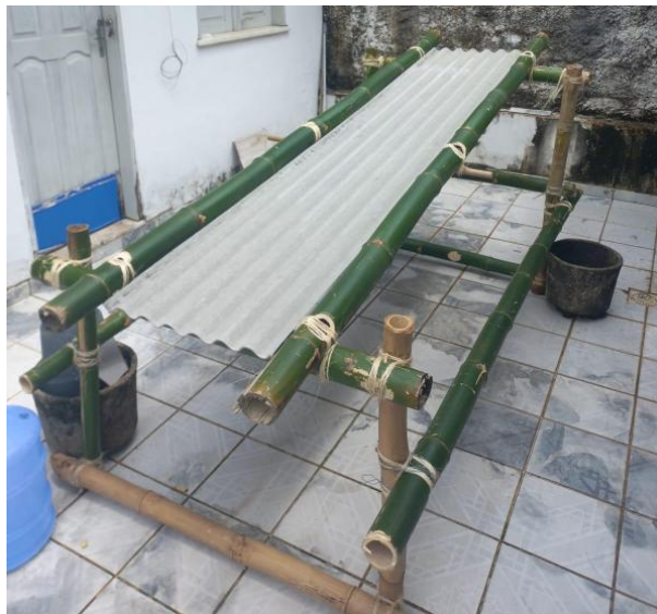
Figura 17 - Estrutura de bambu para o telhado verde.
