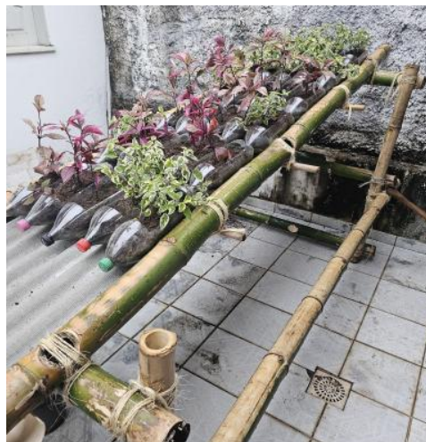
Figura 18 B - Telhado verde modular de baixo custo
