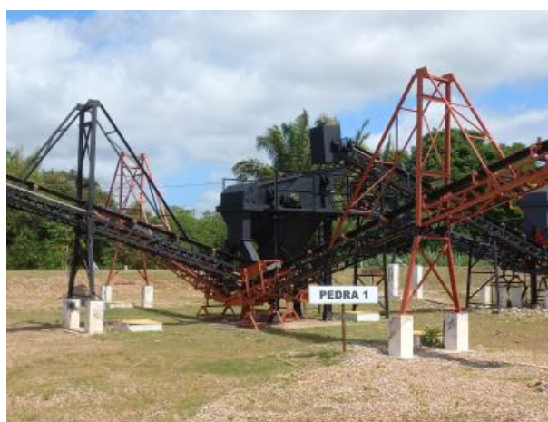
Figura 9 - Usina fixa de reciclagem de RCC em São Luís/MA
