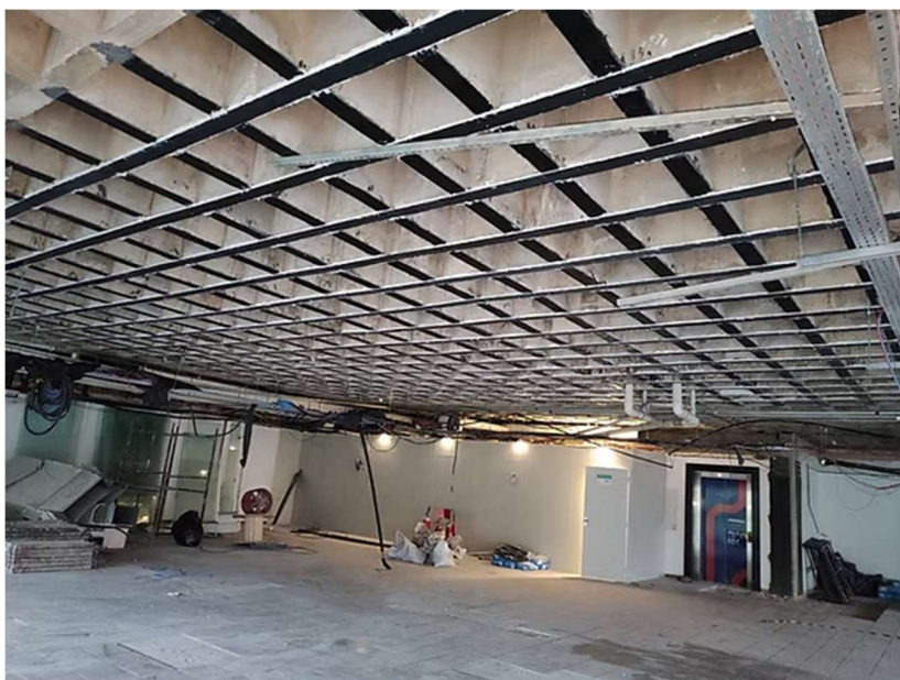
Figura 3 - Reforço estrutural em laje nervurada
