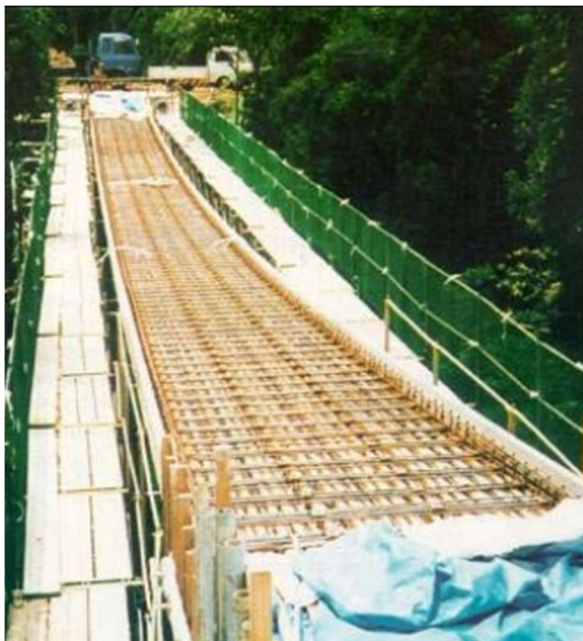
Figura 8 – Pontes de concreto armado com barras de FRP, no Japão
