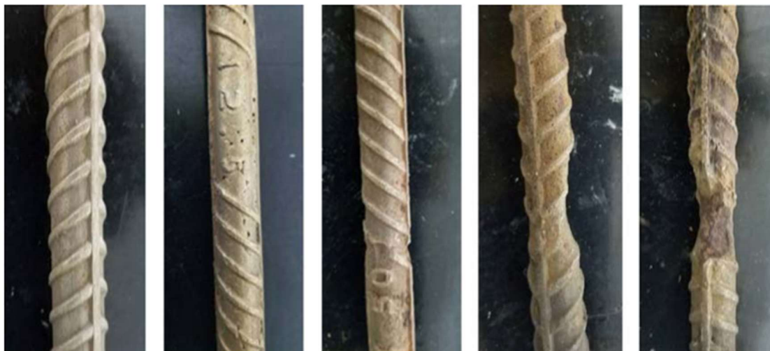
Figura 4 – Progressão da corrosão em barras de aço
