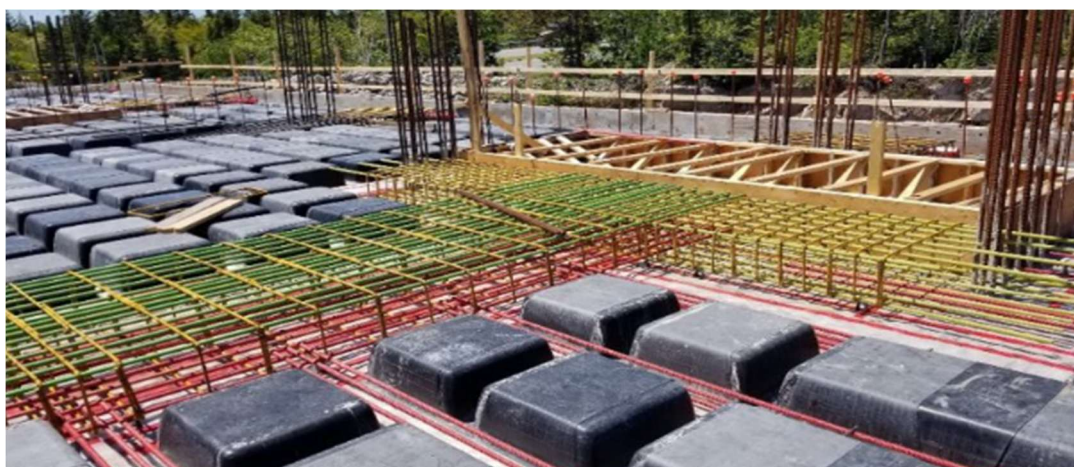
Figura 6 – Armadura de GFRP das lajes nervuradas bidirecionais
