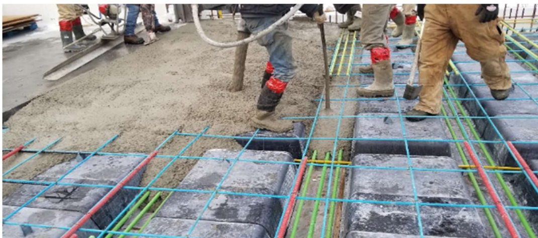
Figura 5– Concretagem de laje nervurada armada com GFRP
