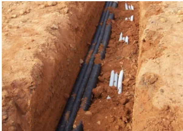
Figura 13 – Cabo de fibra óptica blindado.
