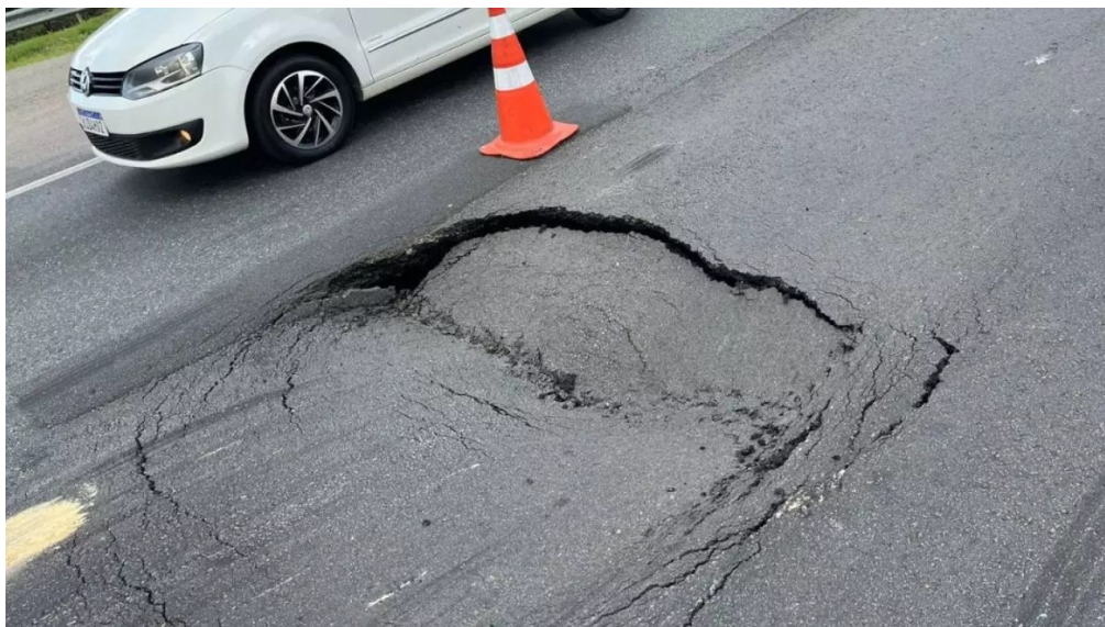
Figura 3: Afundamento asfáltico
