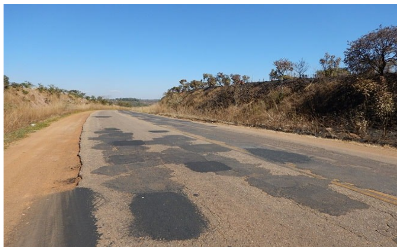
Figura 5: Remendos asfálticos
