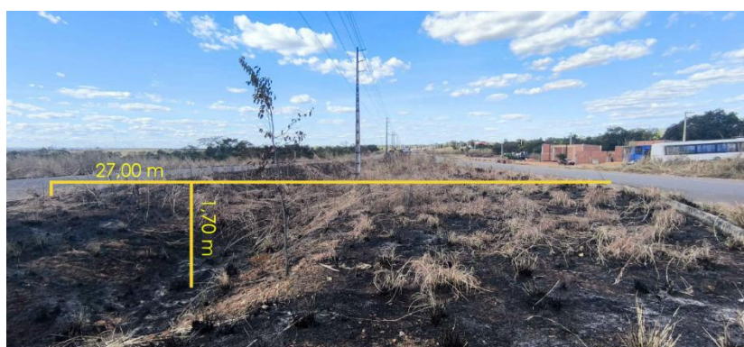
Figura 17 - Seção transversal da vala existente
