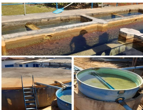
Figura 6 – Estação de tratamento de água de Balsas – MA
