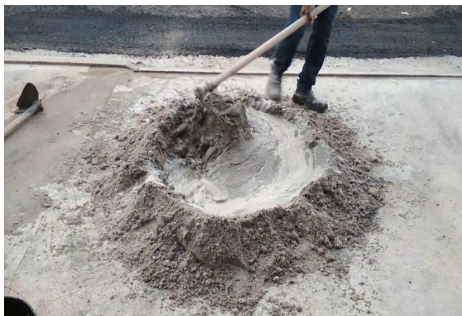
Figura 19: Preparo da massa de cimento para utilizar na obra.
