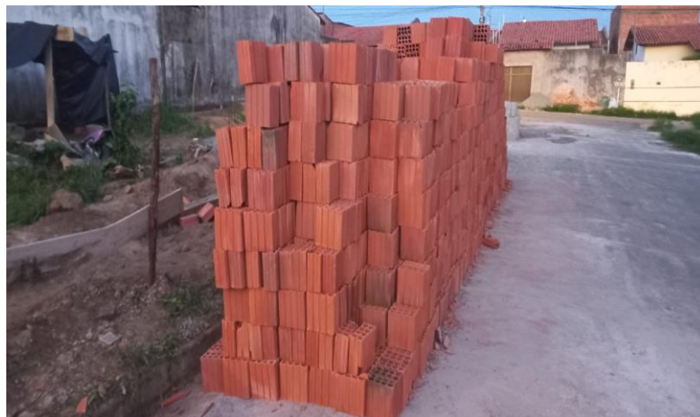
Figura 20: Tijolos para ser utilizados na obra.
