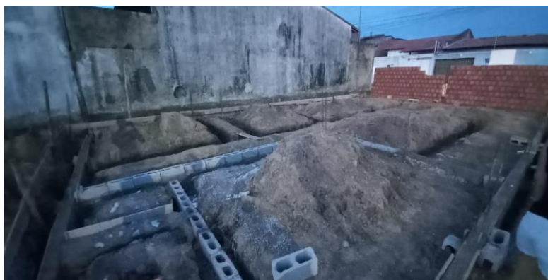
Figura 9: divisão dos cômodos e a construção do alicerce.
