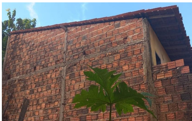
Figura 15: Inclinação do telhado, com telhas de barro.
