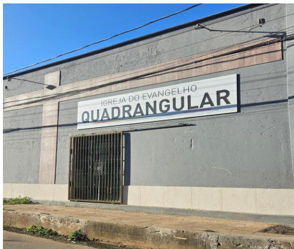
Figura 1: Fachada da igreja
