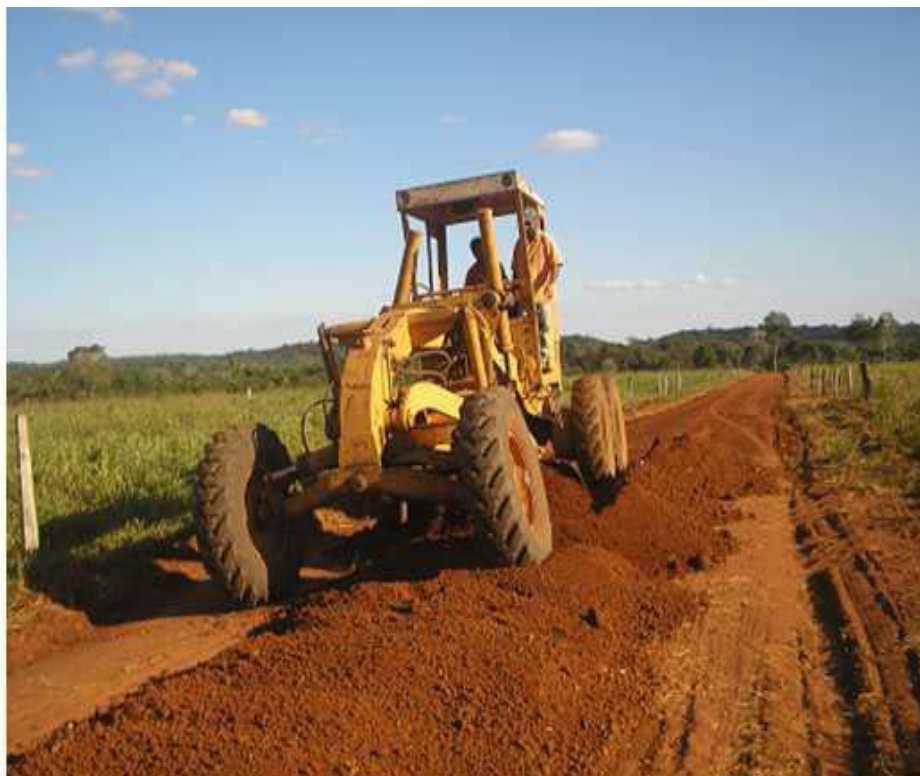
MELHORIA DA INFRA-ESTRUTURA RURAL: PONTES E ESTRADAS VICINAIS RECUPERADAS.
