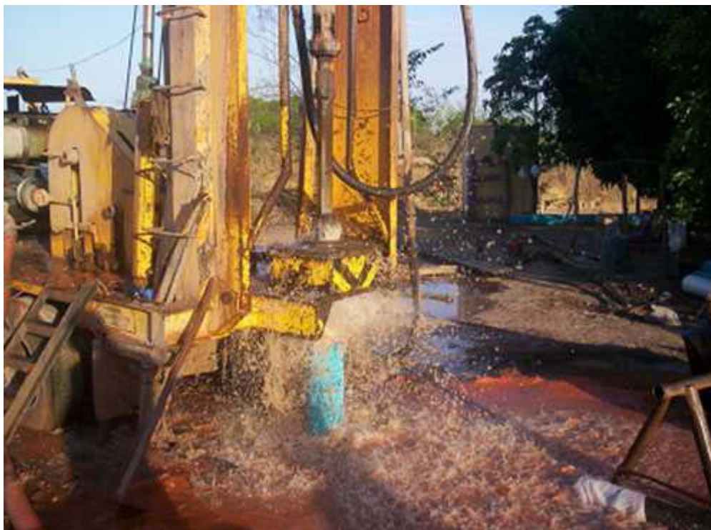
PERFURAÇÃO DE POÇOS ARTESIANOS EM TODA A ZONA RURAL E BAIRROS DA ZONA URBANA
