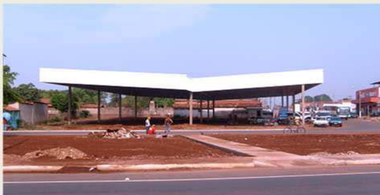
CONSTRUÇÃO DO NOVO TERMINAL RODOVIÁRIO DE PORTO FRANCO
