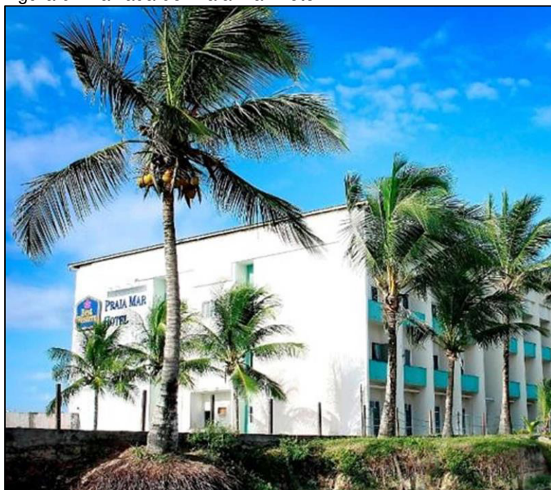
Figura 9 - Faixada do Praia Mar Hotel
