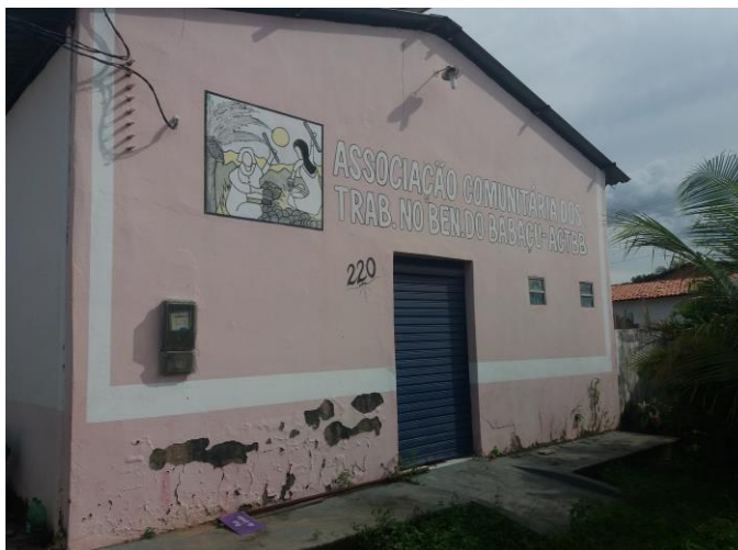
Figura 7: Prédio I da ACTBB, Codó Novo, Codó-MA.
