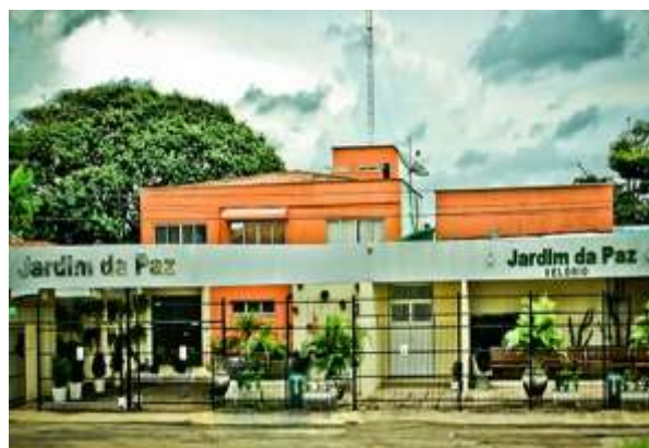
Figura 5 - Central de velórios em Ribamar
