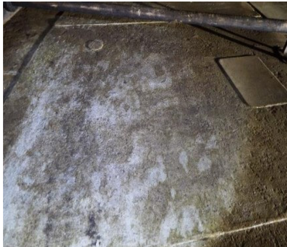
Figura 25 - Vista das chapas laterais.
