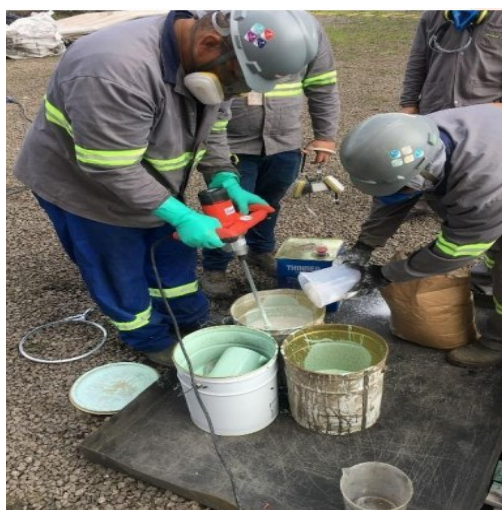
Figura 48 - Mistura da resina e cargas minerais para formação da massa polimérica.
