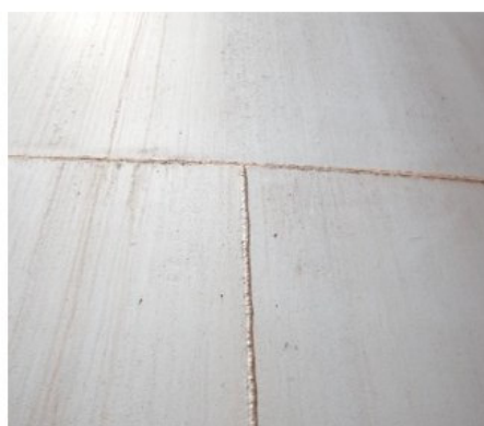
b) Vista das juntas soldadas
