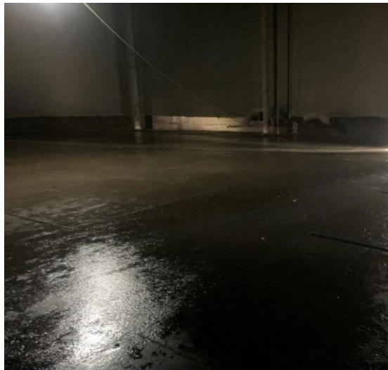
Figura 46 - Aplicação da camada de Ecoprimer D no costado e chapas de fundo.
