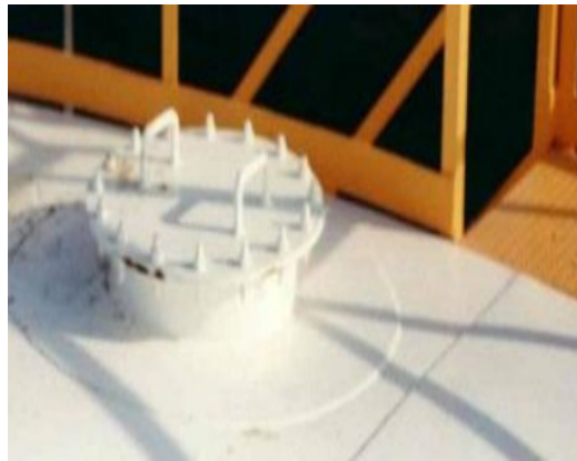
Figura 9 - Boca de visita do teto
