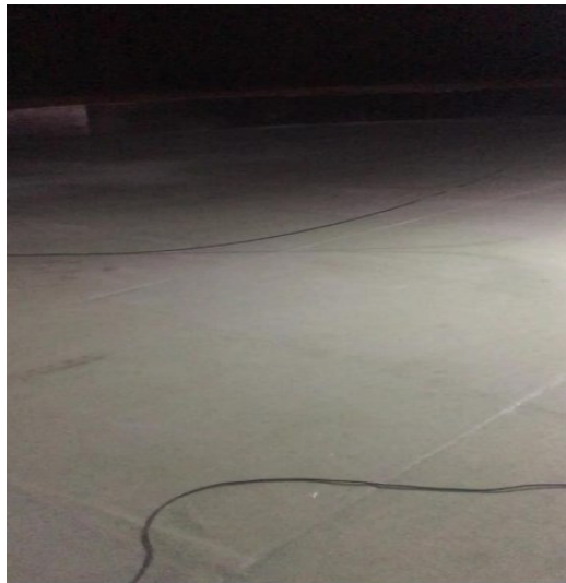
Figura 52 - Processo final após o revestimento de reforço.
