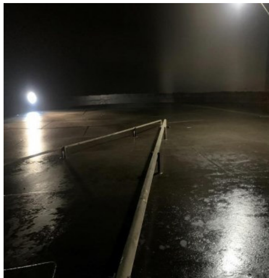
Figura 47 - Aplicação da camada de Ecoprimer D.
