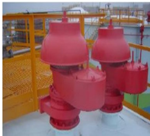
Figura 6 - Válvula de pressão e vácuo.
