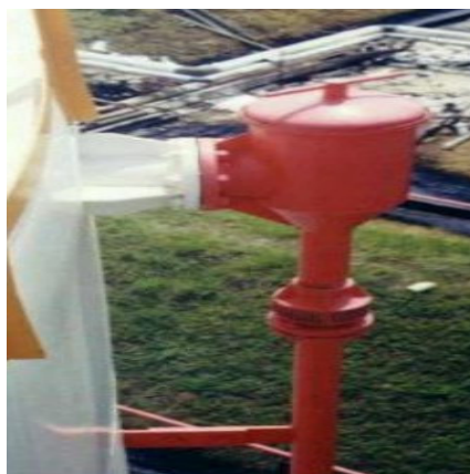
Figura 10 - Câmara de espuma de um tanque.
