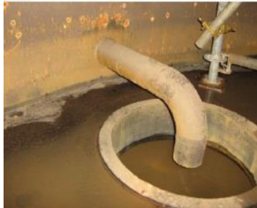
Figura 7 - Sifão de um tanque de armazenamento.
