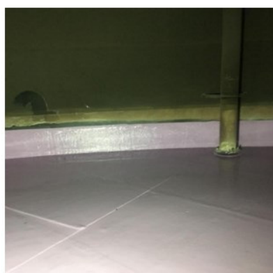
a) Tanque com revestimento final no fundo e costado
