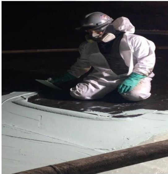
Figura 49 - Aplicação da camada base.
