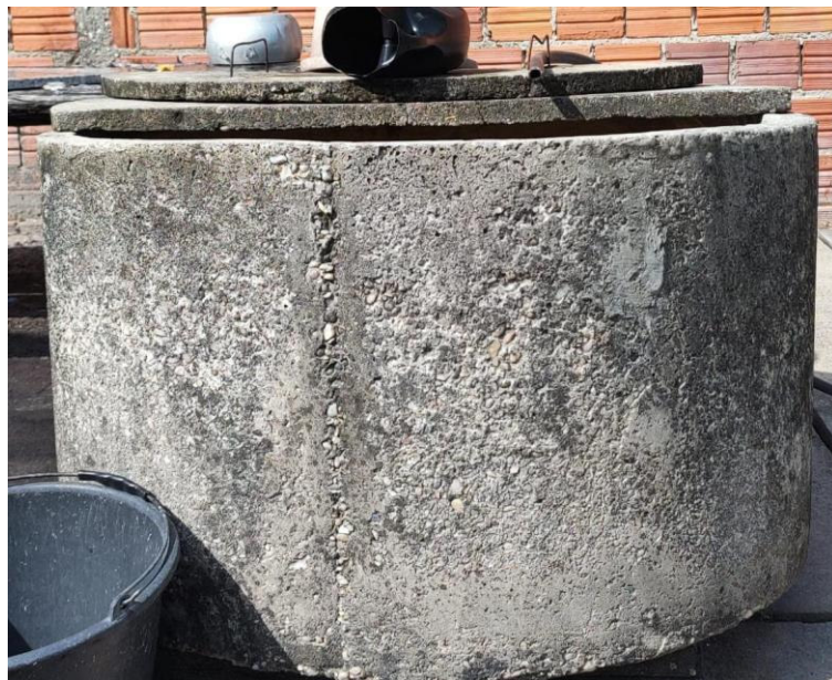
Figura 26. Reservatório de água apoiado.
