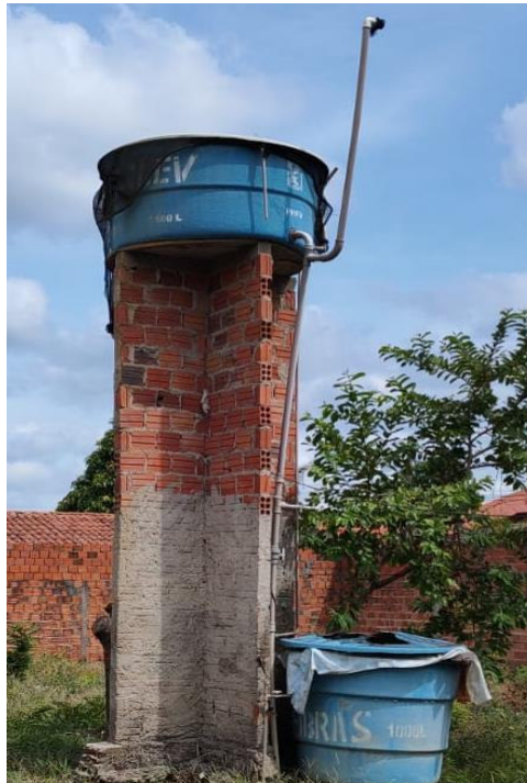
Figura 27. Reservatório de água apoiado.
