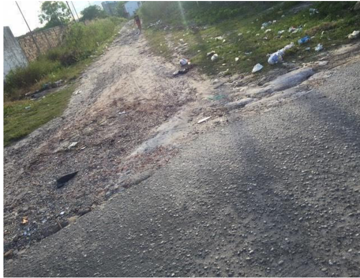
Figura 16. Local de disposição incorreta de lixo.
