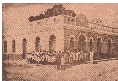
Edificação com estudantes em sua fachada.
