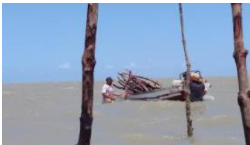
Figura 13: Madeira sendo levada na canoa para o local de construção do curral.
