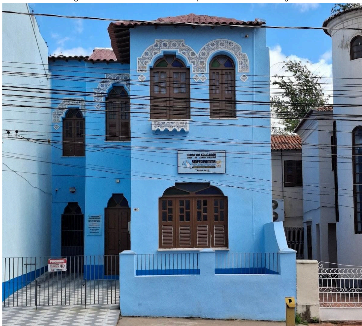
Figura 17: Adornos na fachada bem preservados na rua do Egito
