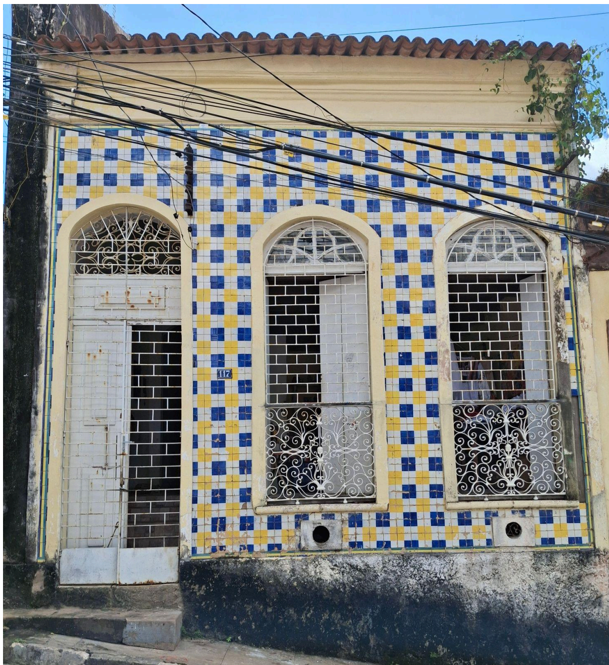
Figura 02: Técnica tapete na fachada de uma casa na Rua Isaac Martins (Barrocas)
