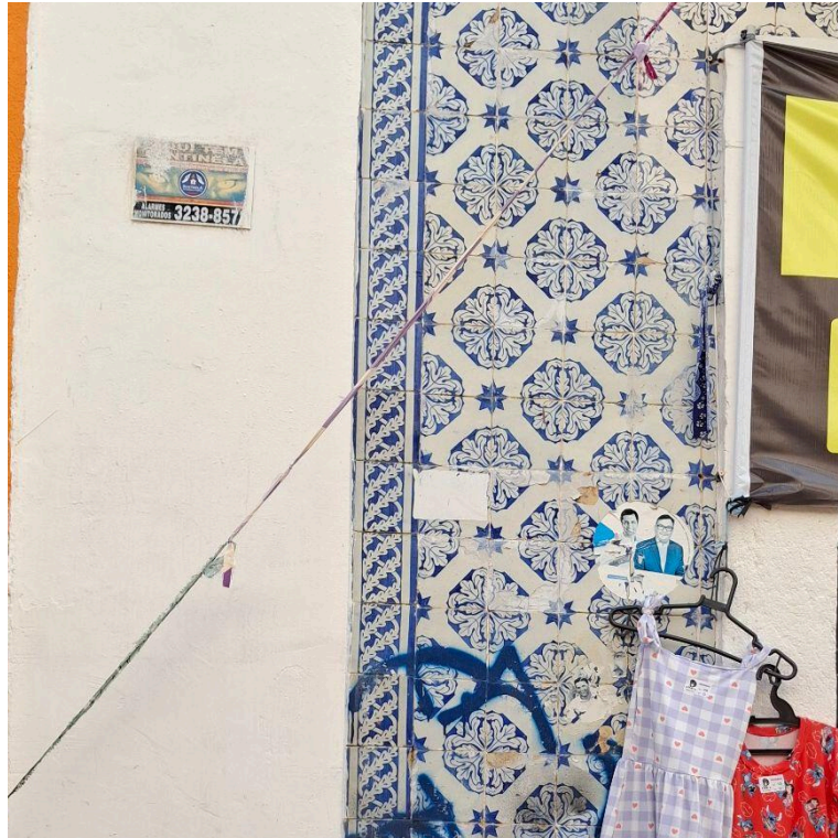
Figura 03: Cercadura demarcando a limitação dos azulejos, separando as fachadas
